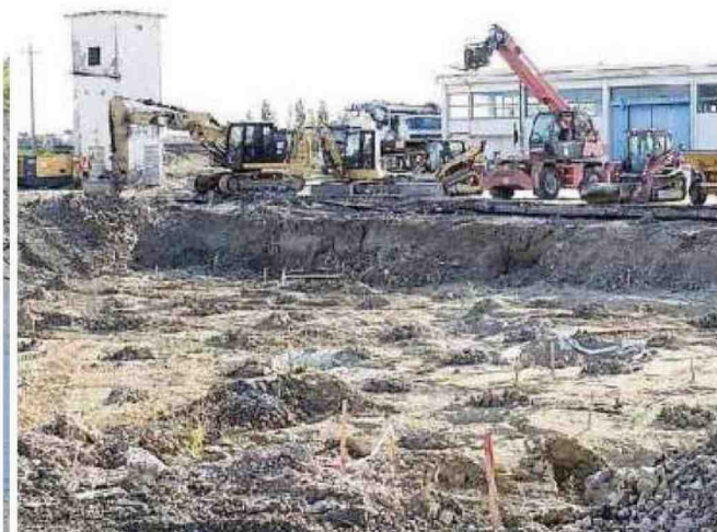
L'area di cantiere in località Campalto
